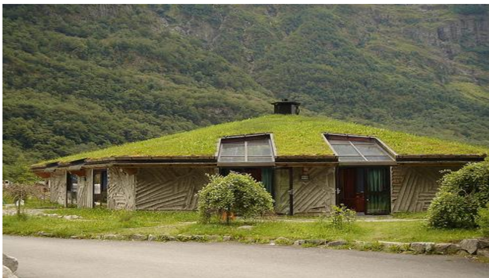
Imagem 1 – Demonstração de uma casa com Telhado Verde
