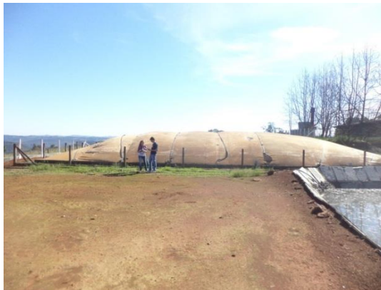
Figura 01: Sistema biodigestor anaeróbico de dejetos suíno - Fonte: os autores.
