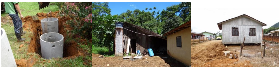
Projeto em andamento na cidade de Schroeder/SC
